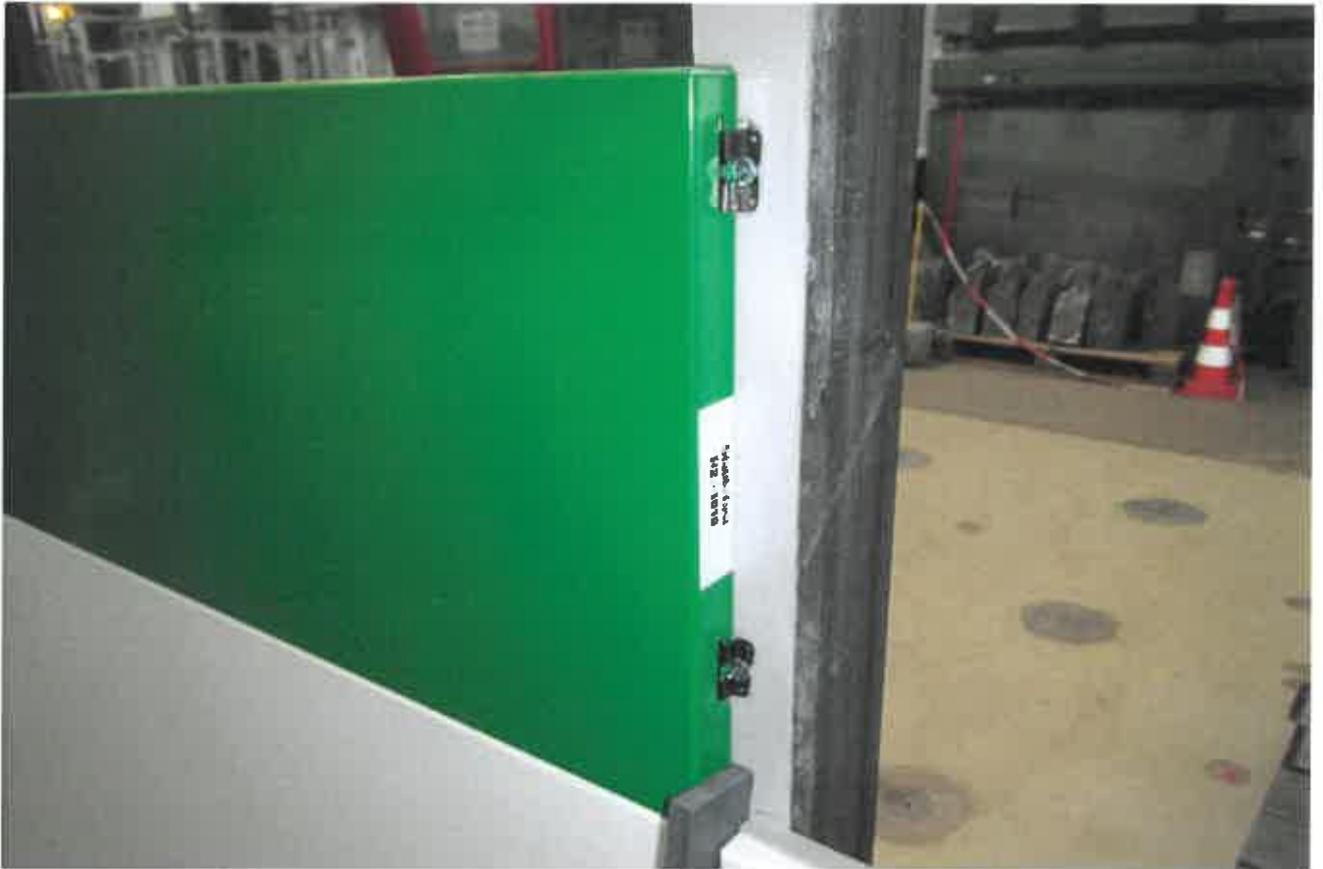
**Bild A.6.1:** Die Bepankung wird über Befestigungsklemmen, H102-0007-02, mit den Tragprofilen, Senk-Bohrschraube 3,5 x 13, H422-0240, verschraubt
