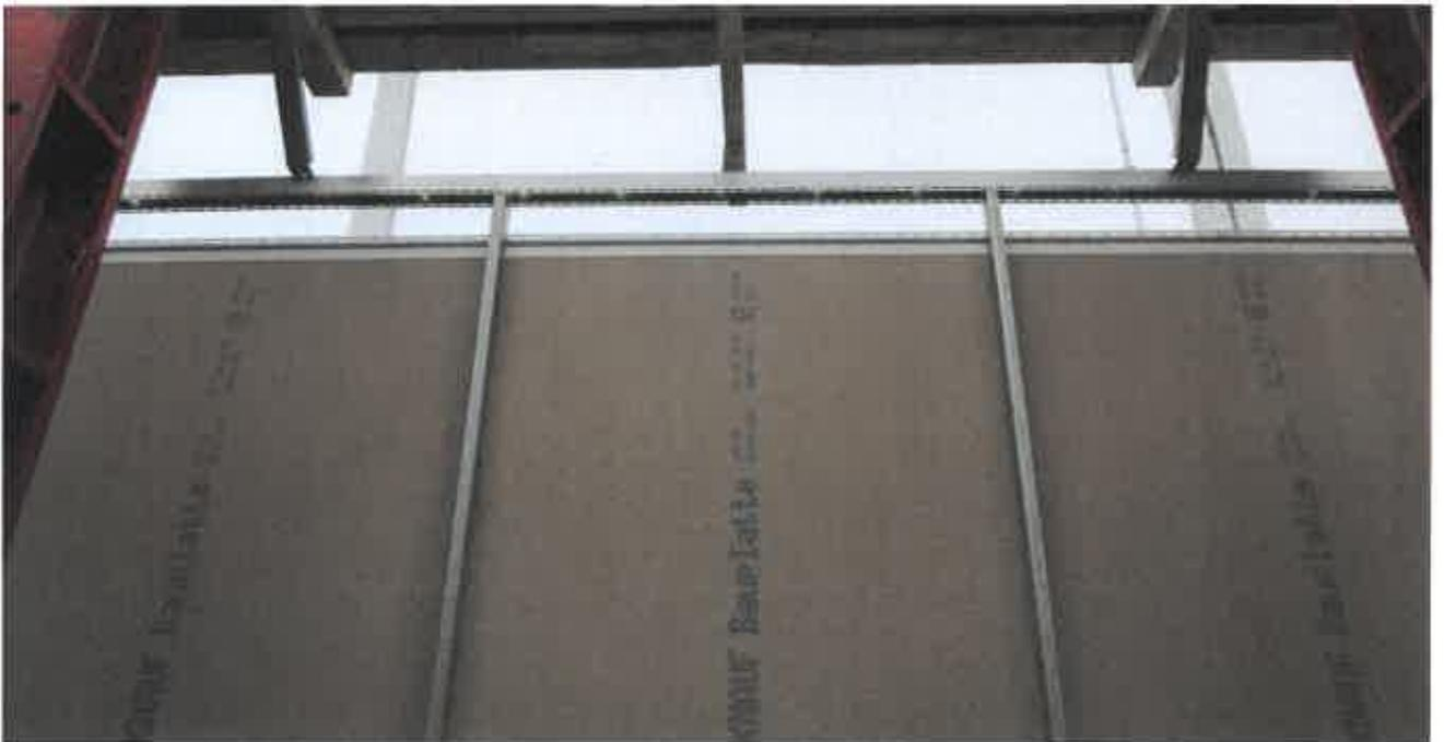
**Bild A.5.2:** Die GKB-Platten werden in einer Deckenschiene, H101-0008 01, geführt. Die Deckenschiene ist mit der Sechskant-Bohrschraube, H422-0220, am Profil befestigt
