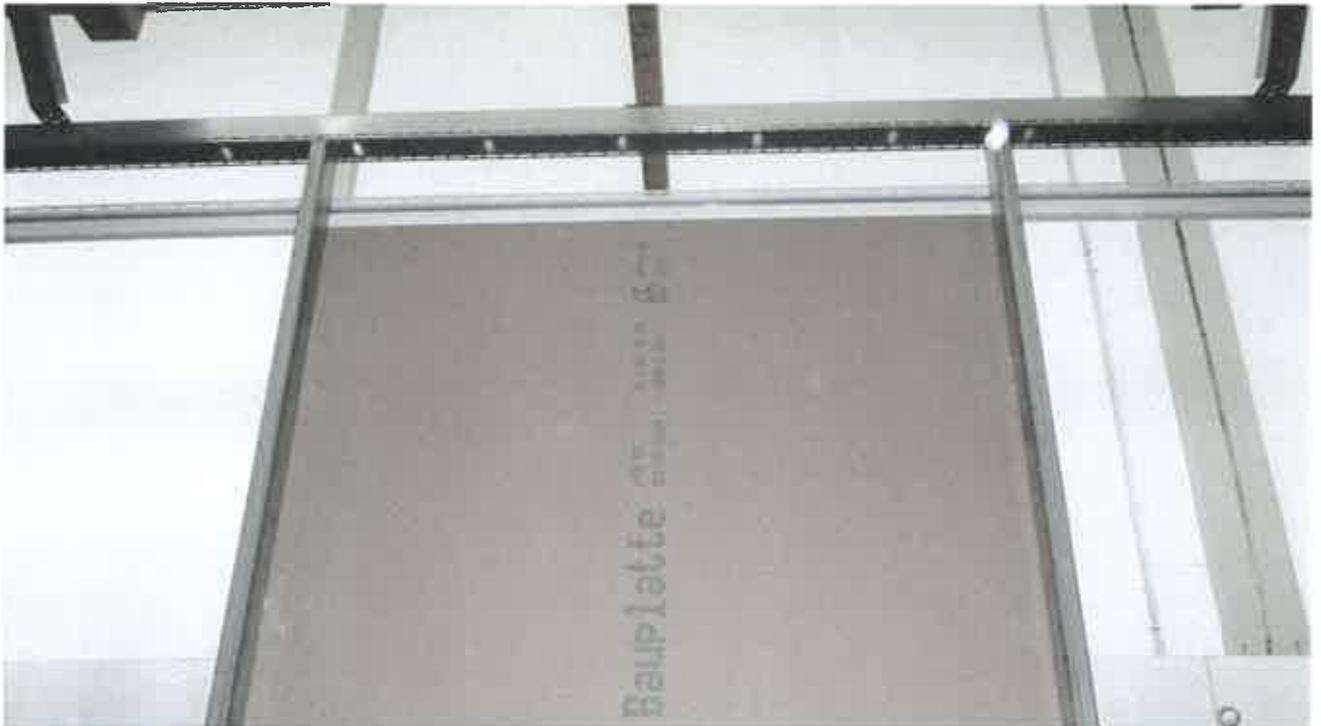
**Bild A.4.2:** Am oberen Rand wird die gleiche U-Schiene montiert. Mit Sechskant-Bohrschrauben 4,8 x 19 werden die Stützenprofile an der U-Schiene verschraubt, H422-0220
