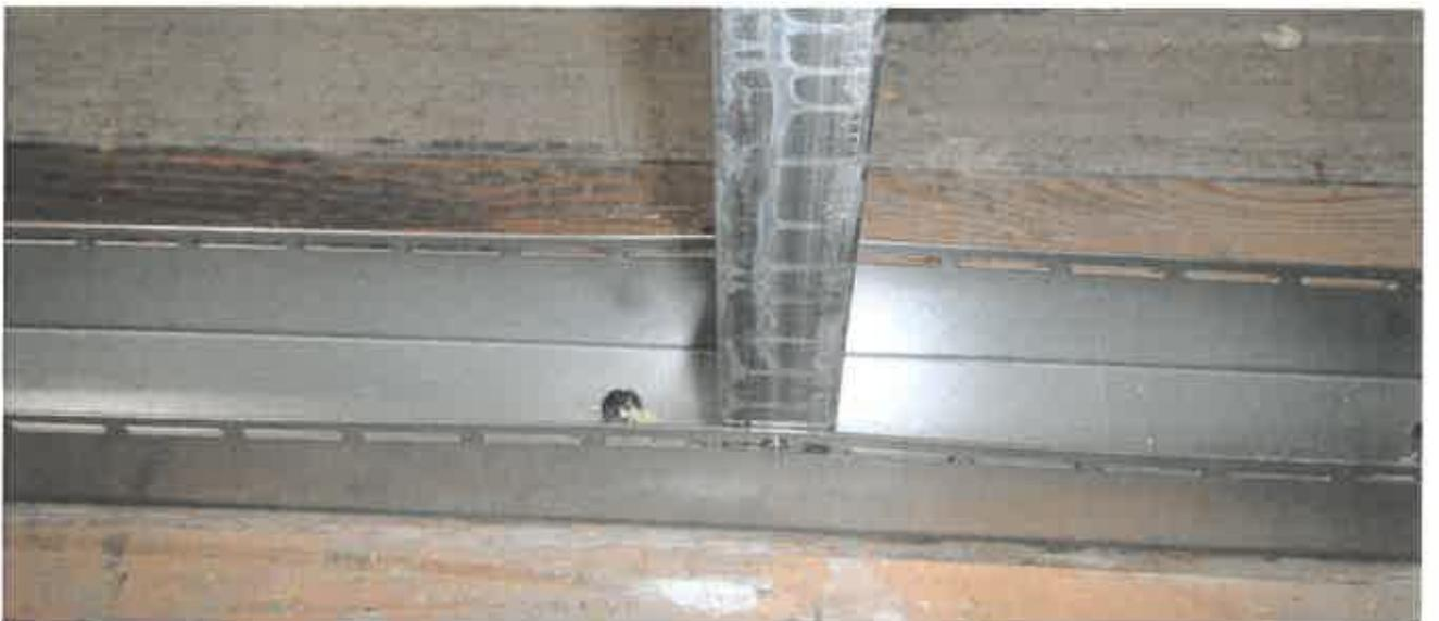
**Bild A.2.3:** Verschraubung Stütze und U-Bodenschiene Seite mit Senk-Bohrschraube 4,2 x 13, H422-0240
