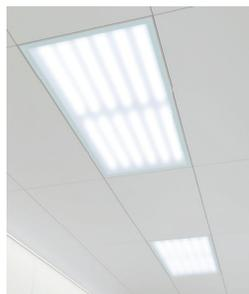
Hygieneraum mit Metallkassettendecke im Standardraster 600x1200 mm, mit flächenbündig integrierten LED-Leuchten
